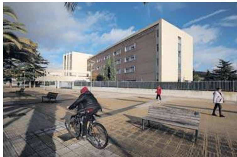
La Residencia de las Hermanitas de los Pobres en Pamplona.
